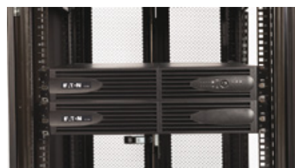
Die Eaton 5130 USV benötigt zwei Platzeinheiten (U bzw. He) im Rack und das optionale Batteriemodul braucht ebenfalls 2U bzw. 2He.
